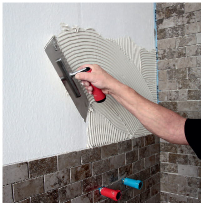
6. Når PCI Lastogum-membranen er tør, kan der opsættes fliser.
