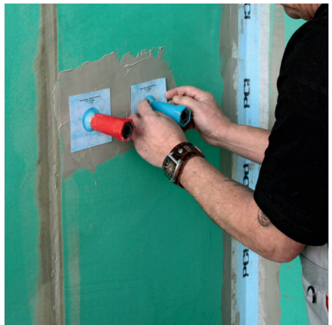
2. Monter PCI Pecitape 10 x 10 ind over rørtislutningen, der stikker ud af væggen, og klæb den fast med PCI Lastogum (grå).
