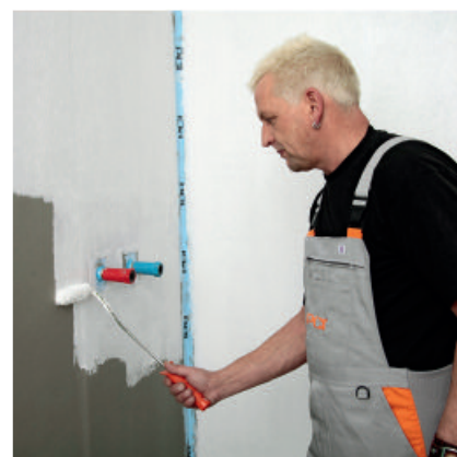
PCI Lastogum påføres underlaget ufortyndet med rulle, pensel eller spartling.
