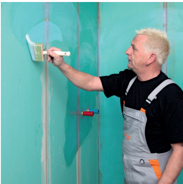
1. Grundning: Sugende mineralske eller gipsholdige underlag og gipskartonplader grundes med PCI Gisogrund.
