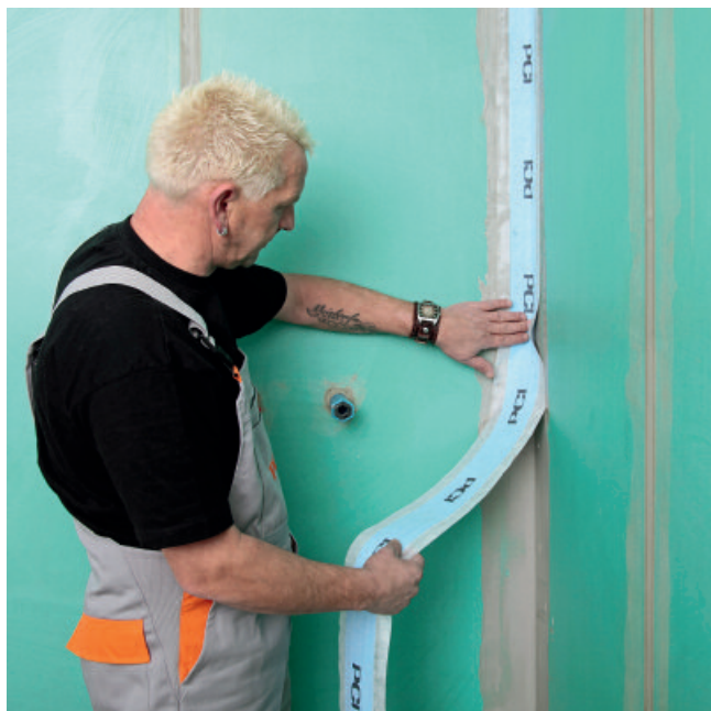
3. Tætningsbåndet PCI Pecitape 120 fastklæbes i hjørnefuger og gulv/væg-samlinger med PCI Lastogum (grå).
