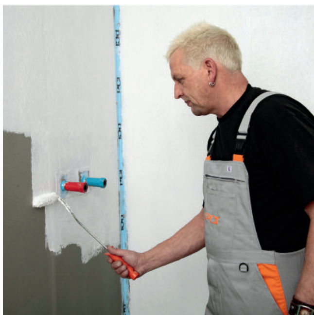
5. Påfør det andet membranlag PCI Lastogum (hvid) efter en afluftningstid på ca. 1 time. Undgå, at det første lag PCI Lastogum (hvid) skinner igennem; om nødvendigt gentages behandlingen.
